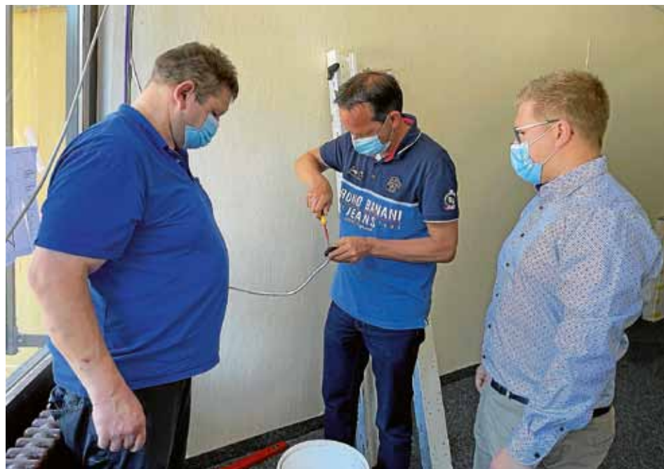
Unter fachkundiger Aufsicht hilft „Praktikant“ Dörflinger bei der Elektroinstallation im Bischof-Sproll- Bildungszentrum Rißegg. Foto: Büro Thomas Dörflinger
